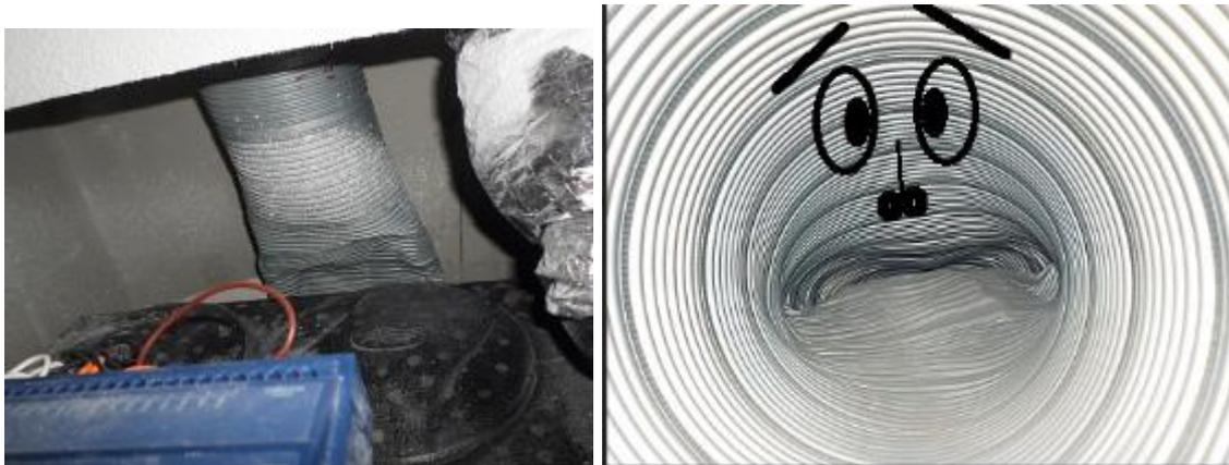
*Figure 5 : Exemple d'écrasement constaté lors de la campagne d'essai in-situ:*
