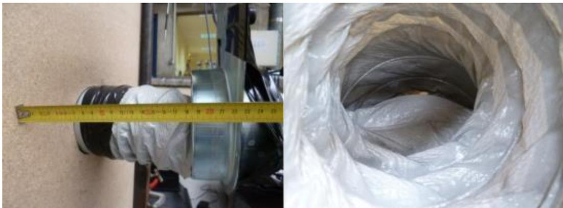
Figure 3 : Raccordement sur un conduit flexible écrasé
